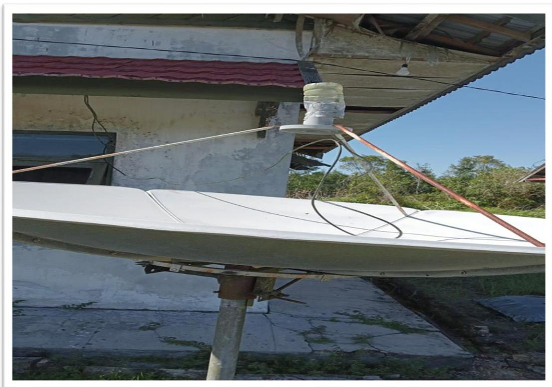
*Disk Parabola DVB untuk menangkap sinyal audio dari satelite*
